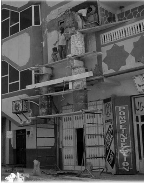
Qualidade da mão de obra
