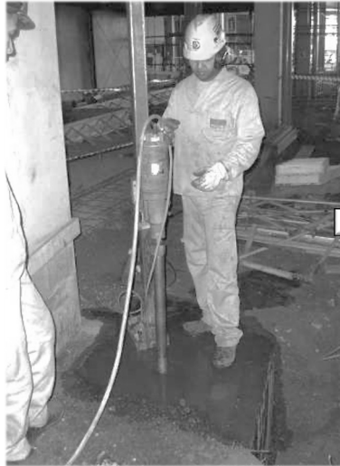
Fundação da coluna C96
