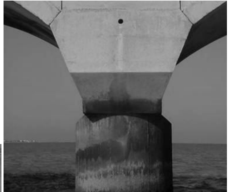
Vista lateral, Cara Este.
