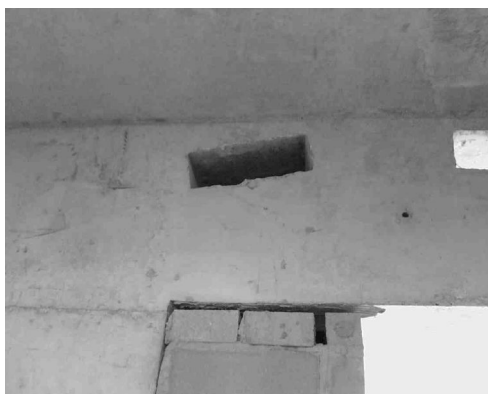
Furo em viga
