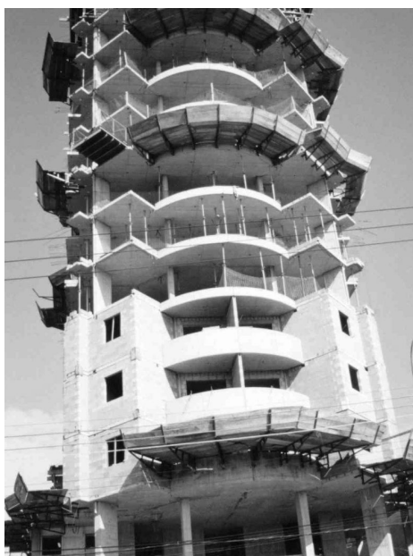
Edif. Em laje plana protendida
