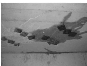
Chumbador de fixação da grua
