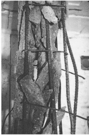
Configuração Convencional de Estribos
