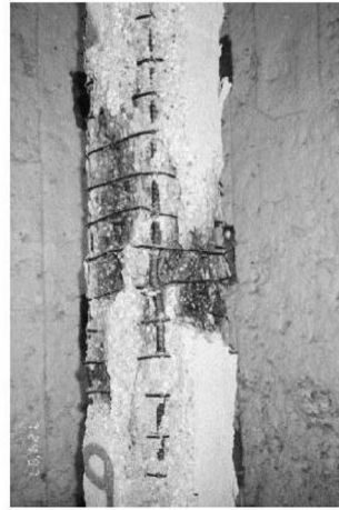
Configuração Modificada de Estribos
