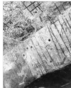
► Figura 9 Imagem de uma das regiões do viaduto onde foram retirados os corpos de prova
