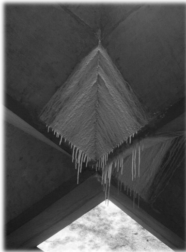
Cobertura do Prédio da FAU-USP
