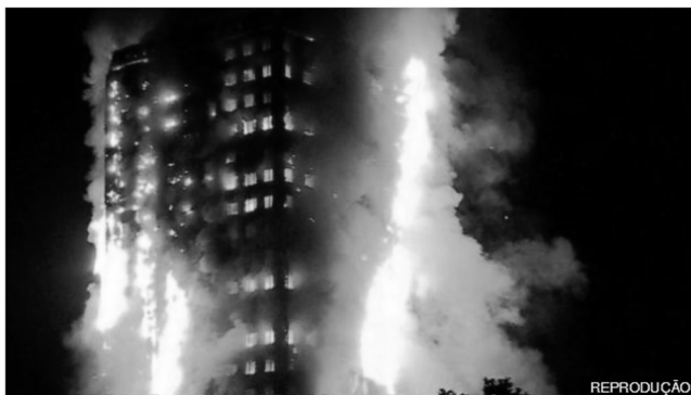
Incêndio no edifício Grenfell, em Londres, no ano passado: revestimento derivado de plástico teria contribuído para que o fogo se espalhasse rápido
