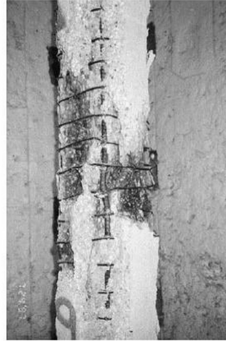
Configuração Modificada de Estribos
