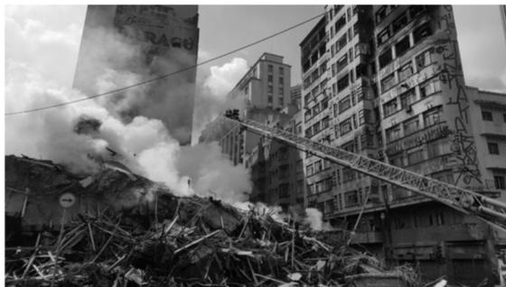
O incêndio e o subsequente desabamento de um prédio de 24 andares no centro de São Paulo nesta terça-feira foram uma "tragédia anunciada" pela falta de sistemas de proteção antifogo, por falta de ação do poder público e pela estrutura mista de concreto e aço do edifício, menos resistente ao fogo.
