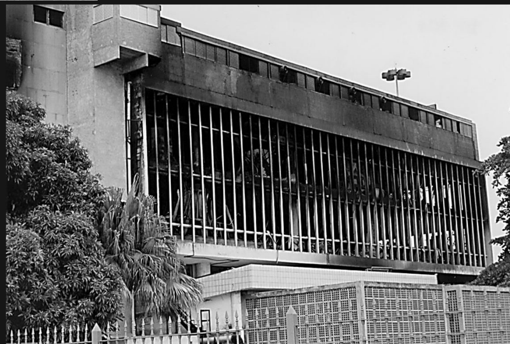
Vista da fachada norte do prédio após o incêndio Brize-soleils danificados
