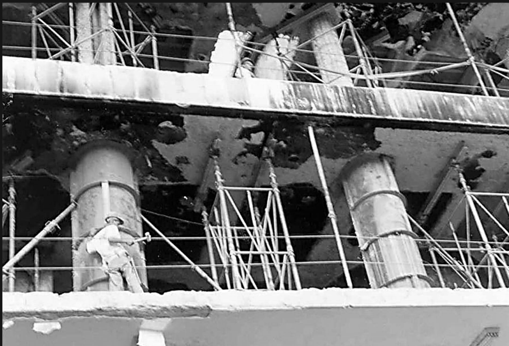
Detalhes da execução do reforço por encamisamento dos pilares da fachada frontal
