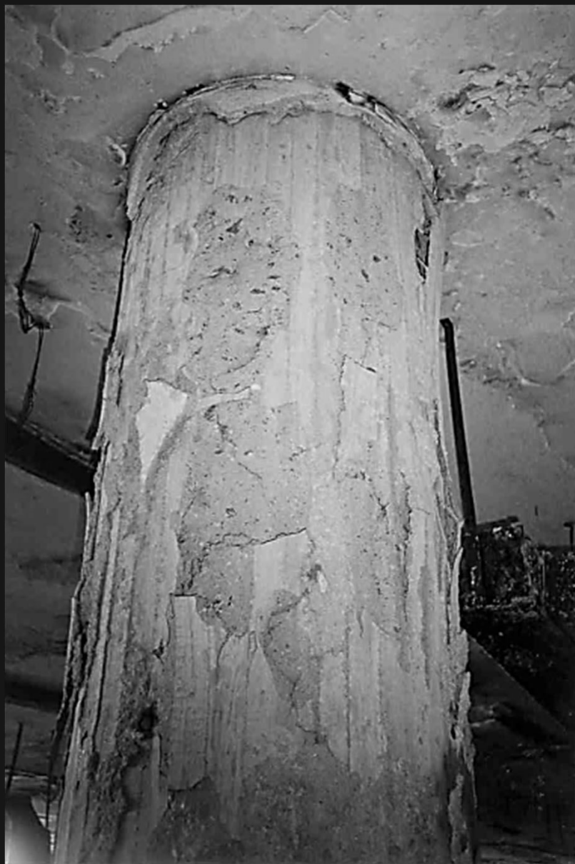
Perda de seção por "lascamento" em pilares do 2º teto.
