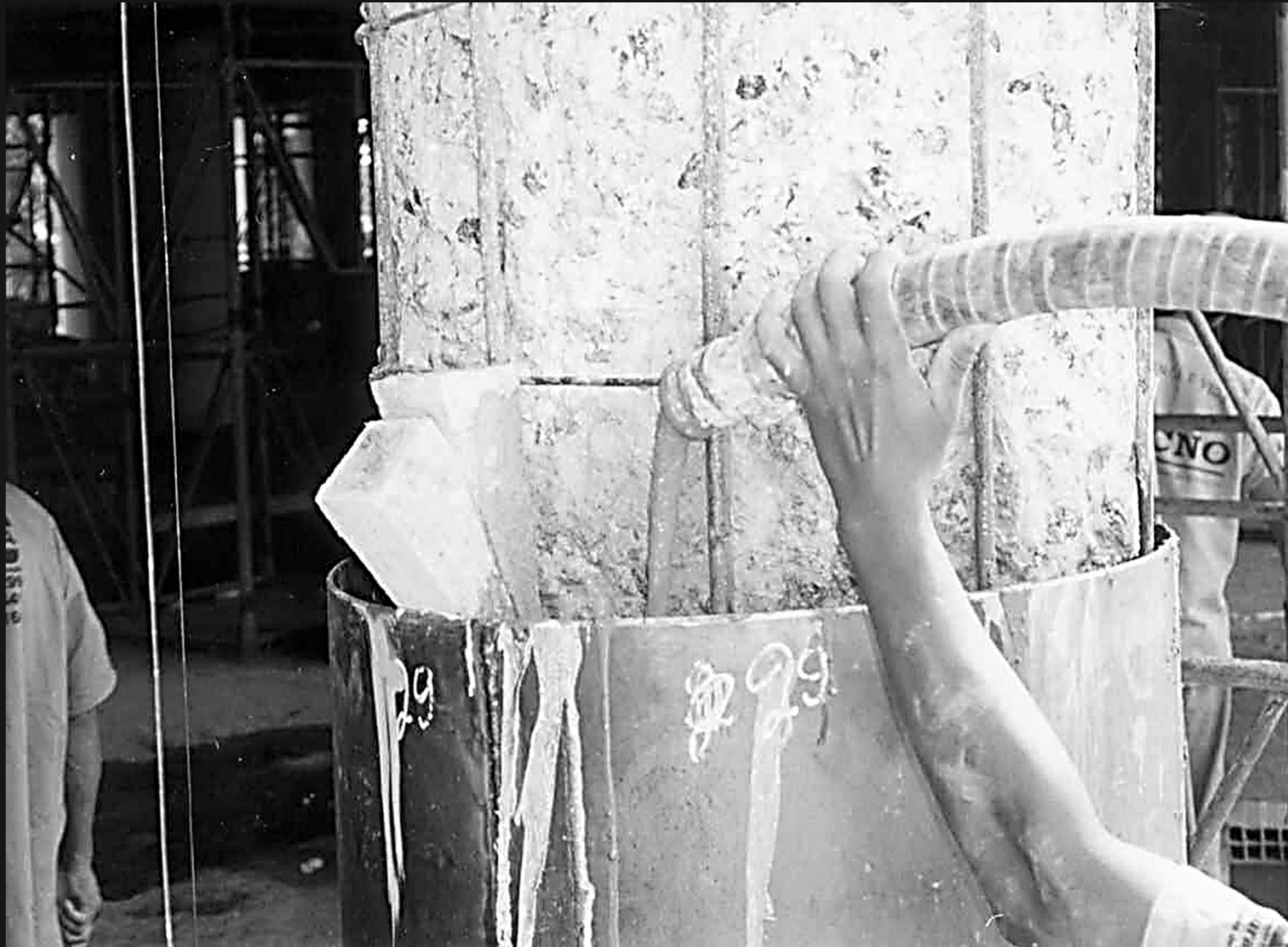
Detalhes da execução do reforço por encamisamento dos pilares
