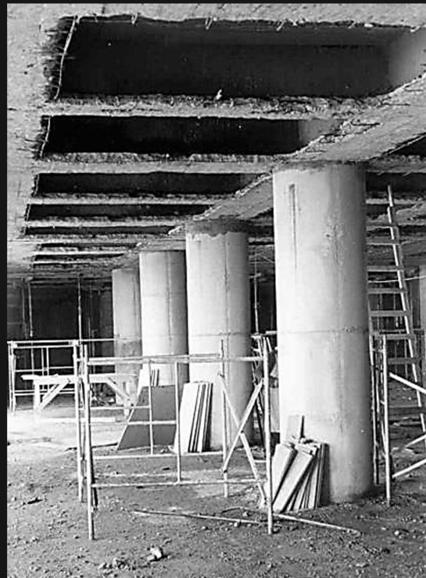
Detalhes dos pilares já reforçados por encamisamento
