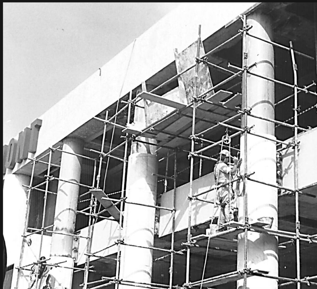
Detalhes da execução do reforço dos pilares da fachada traseira
