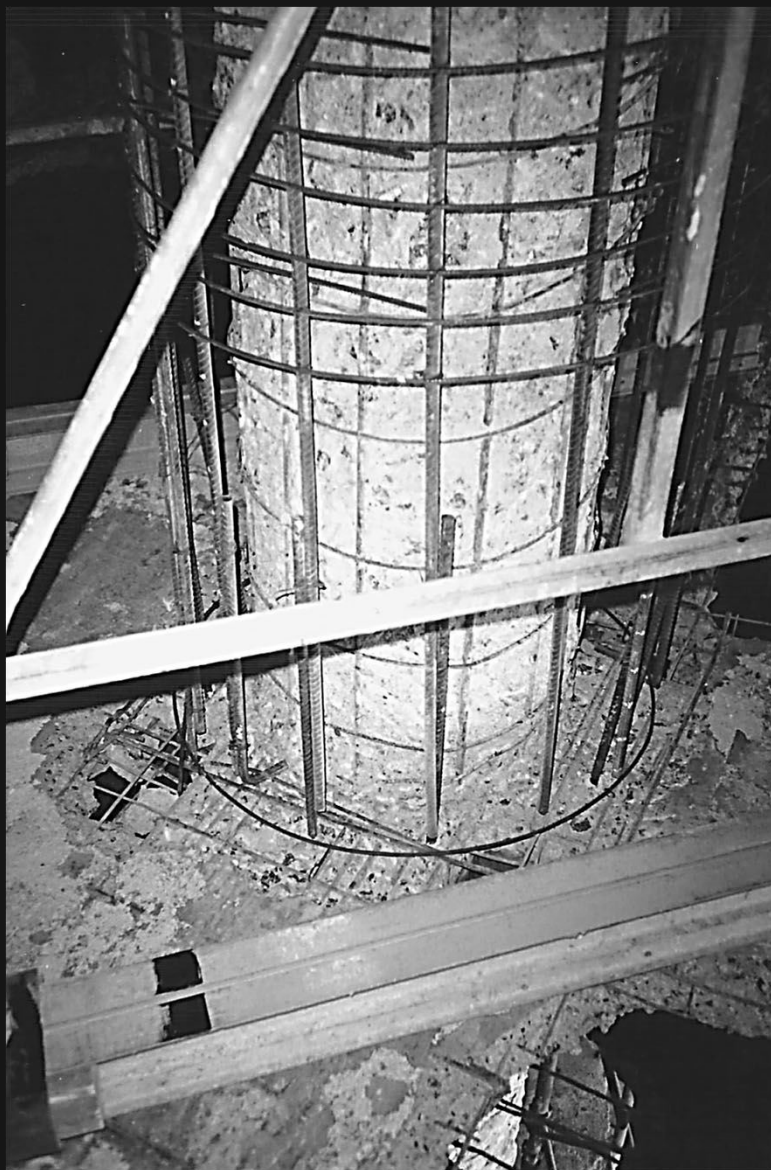
Detalhes da execução do reforço por encamisamento dos pilares
