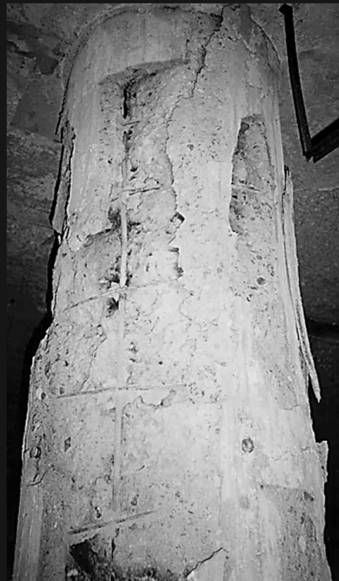
Perda de seção por "lascamento" em pilares do 2º teto.
