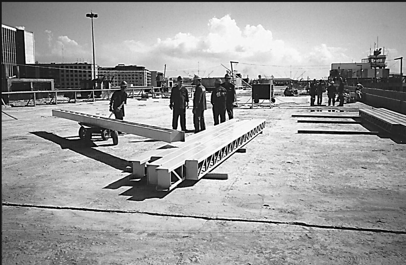
Acabamento da laje de cobertura e construção do telhado
