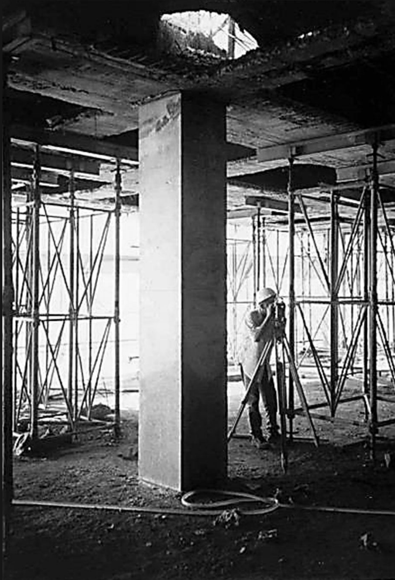
Pilares de seção retangular já reforçados por encamisamento
