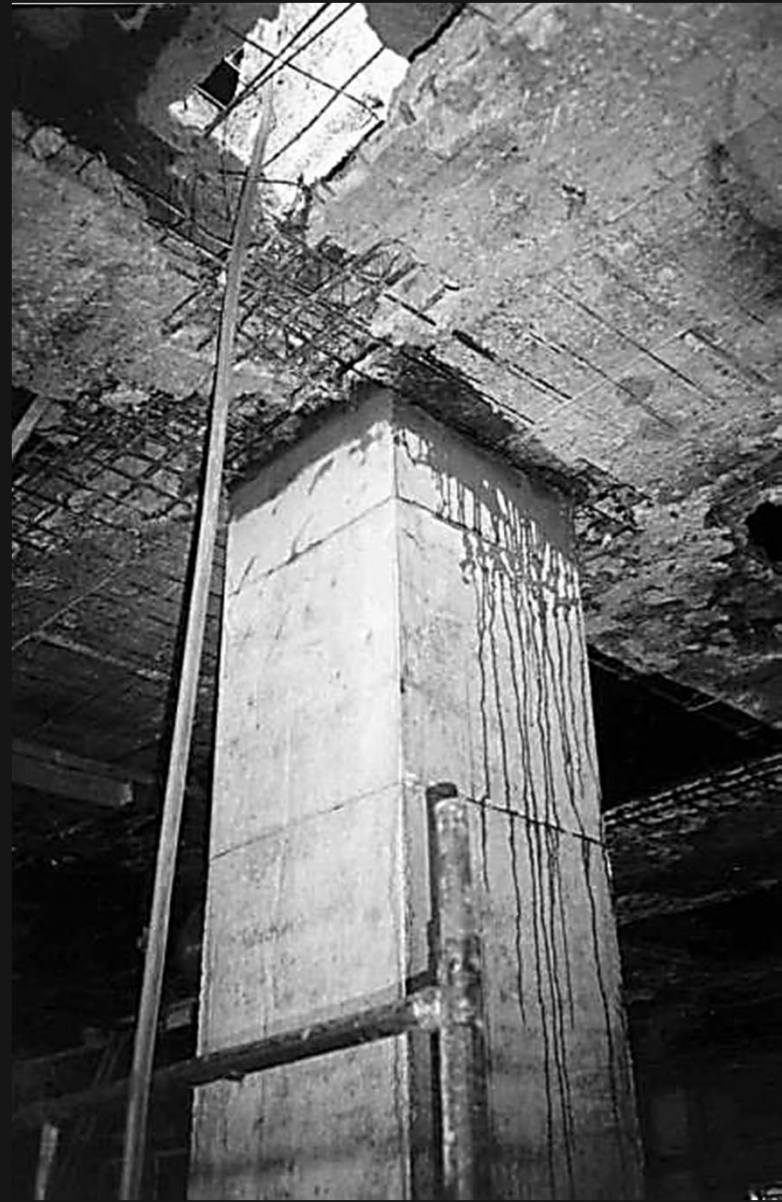
Pilares de seção retangular já reforçados por encamisamento
