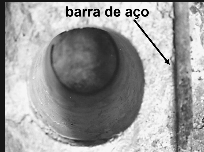
barra de aço Detalhe do ôco cilíndrico deixado pela carotagem.
