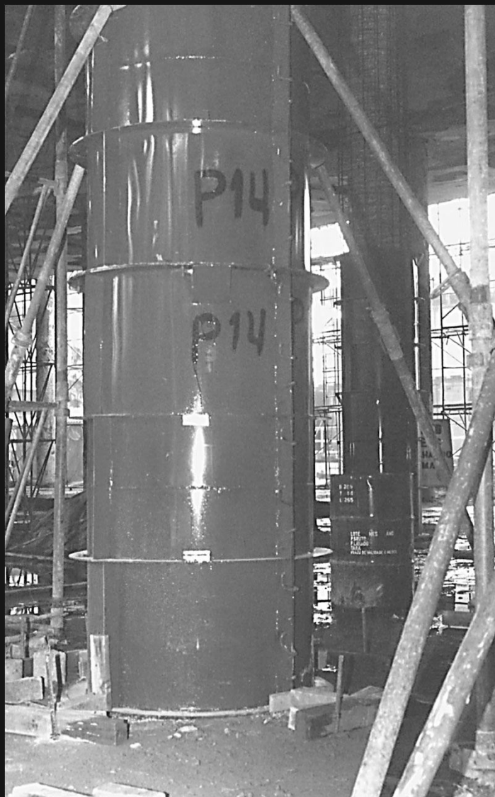
Detalhes das cambotas metálicas empregadas para execução do reforço por cintamento e encamisamento dos pilares do saguão
