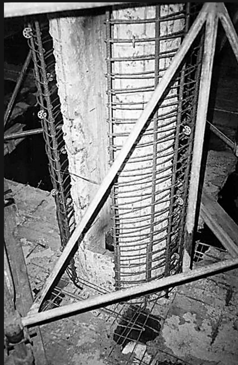
Detalhes da execução do reforço por encamisamento dos pilares
