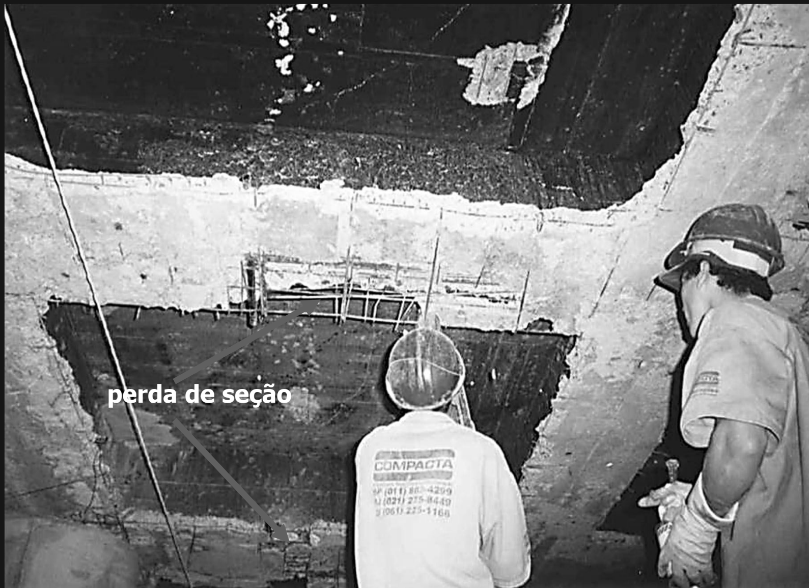
Recuperação das vigas danificadas das estruturas em grelha de todos os tetos
