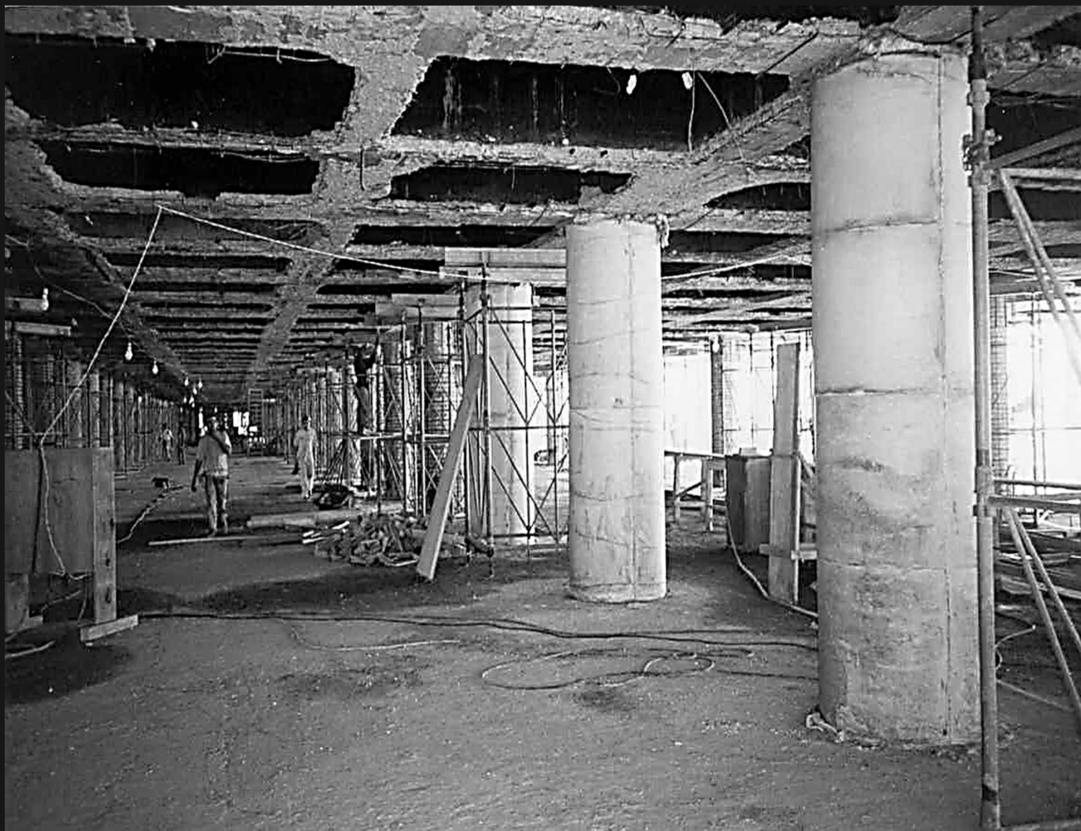
Linha de pilares já reforçados por encamisamento
