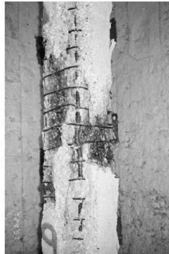
Configuração Modificada de Estribos
