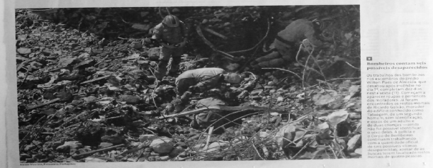
Remanescentes de um prédio destruído em São Paulo. O incêndio no Joazeiro em 1974 levou a mudanças nas normas de segurança para edifícios.
