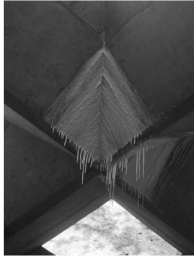
Cobertura do Prédio da FAU-USP
