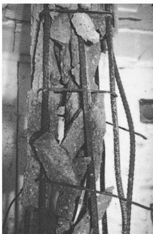
Configuração Convencional de Estribos
