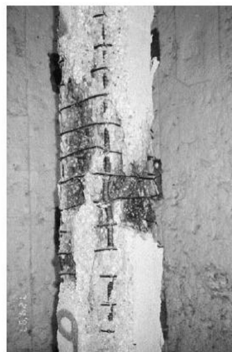
Configuração Modificada de Estribos
