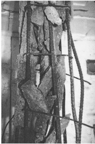
Configuração Convencional de Estribos
