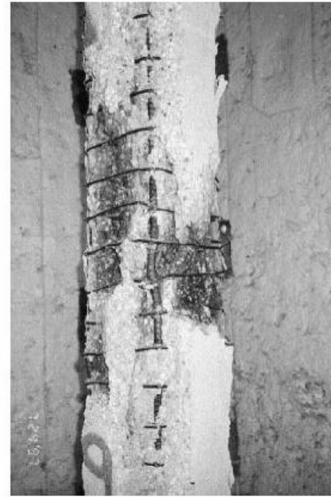
Configuração Modificada de Estribos
