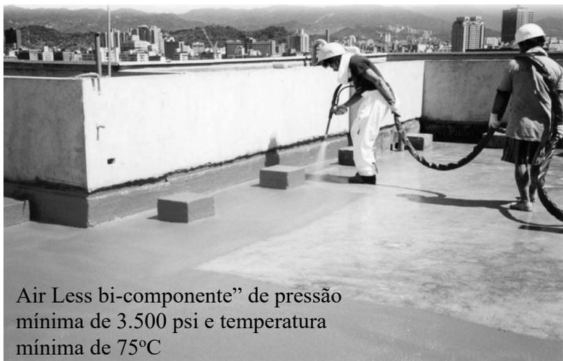
Air Less bi-componente” de pressão mínima de 3.500 psi e temperatura mínima de 75°C
