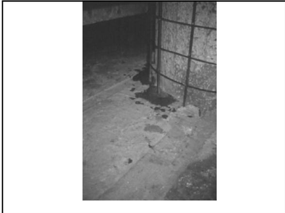
Reparações profundas generalizadas em com **CONCRETO PROJETADO**
