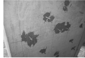
*Fixação pinos utilizando resina epóxi*
