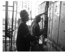
*Execução injeção epóxi p/eliminar "som cavo"*
