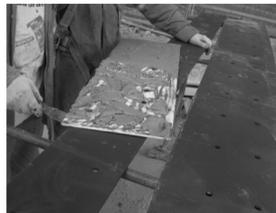
*Espalhar epóxi nas chapas metálicas*
