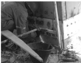
*Corte em excessos de parafusos executados*
