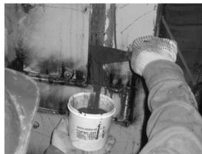
*Colocação epóxi atrás presilhas metálicas*
