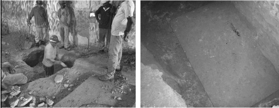
**Escavação de fundação - Vistoria da Sapata e
