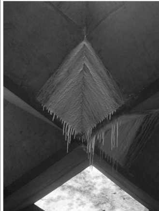
Cobertura do Prédio da FAU-USP
