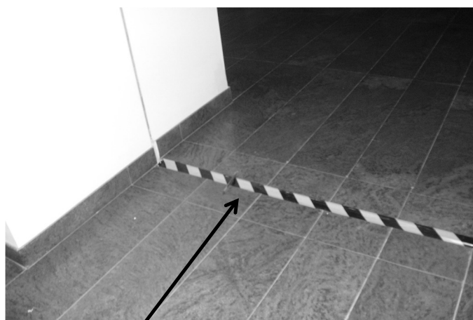
Desnívelamento nível S3
