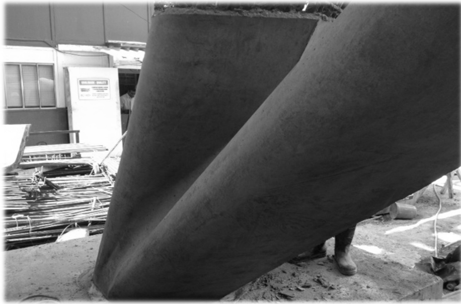
Columna protótipo: concreto SCC (auto-compactable, 50MPa, sin vibrado)
