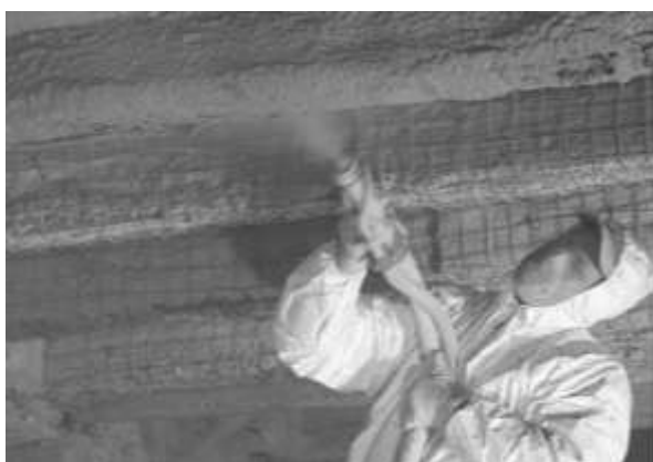
Recuperação de estrutura exposta à INCÊNDIO
