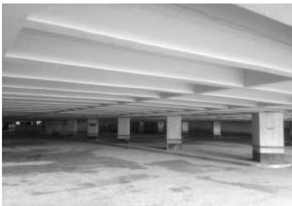
Recuperação estrutural PRAÇA ROOSEVELT
