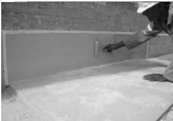
Recuperação de arquibancadas BEIRA RIO
