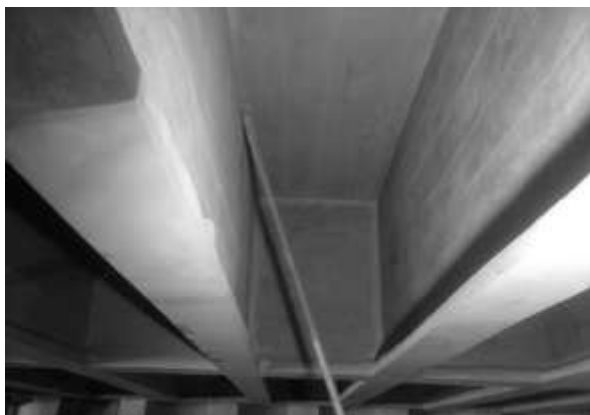
Recuperação estrutural PRAÇA ROOSEVELT
