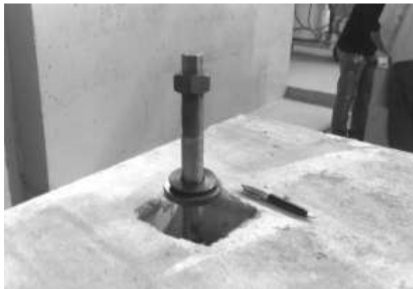
GRAUTEAMENTO EPOXÍDICO de base de máquinas
