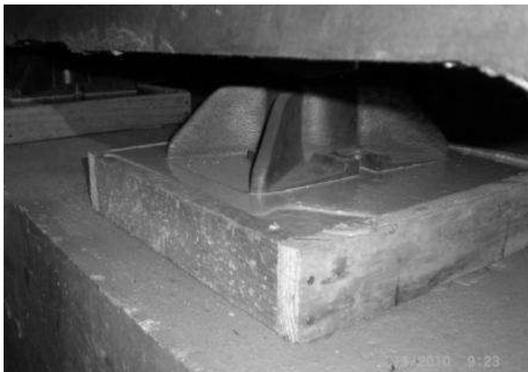
GRAUTEAMENTO EPOXÍDICO de base de máquinas
