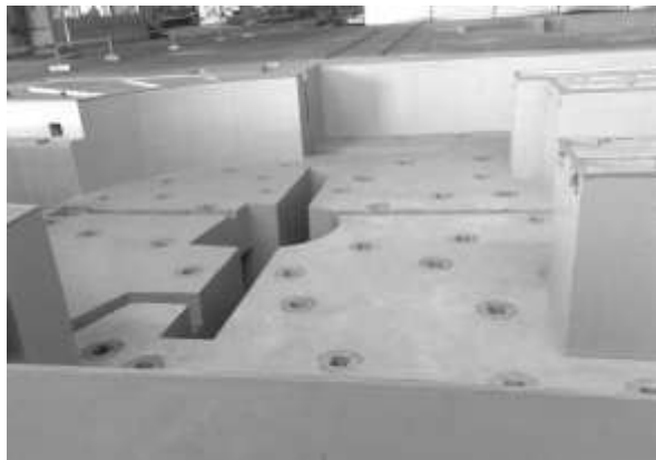
GRAUTEAMENTO EPOXÍDICO de base de máquinas
