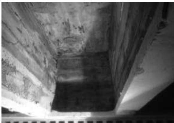
Recuperação estrutural PRAÇA ROOSEVELT
