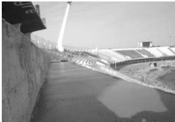
Recuperação de arquibancadas BEIRA RIO
