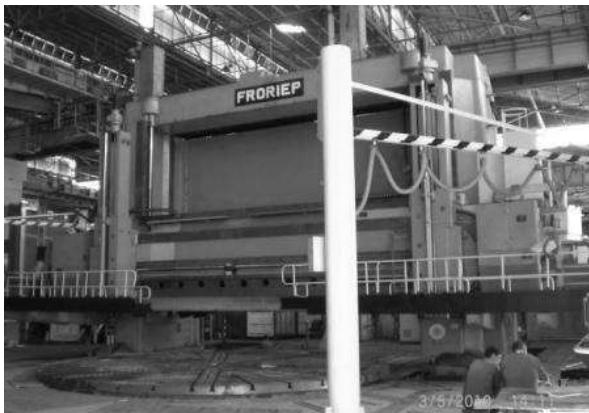
GRAUTEAMENTO EPOXÍDICO de base de máquinas
