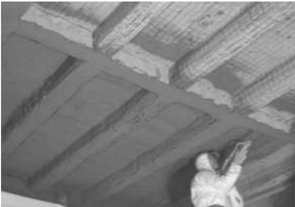
Recuperação de estrutura exposta à INCÊNDIO
