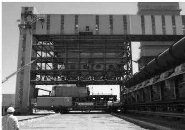
Grauteamento epoxidico de base de trilhos SIDERÚRGICA CSA
