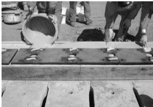
Grauteamento epoxídico de base de trilhos SIDERÚRGICA CSA
