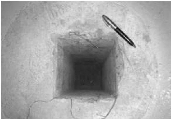
GRAUTEAMENTO EPOXÍDICO de base de máquinas
