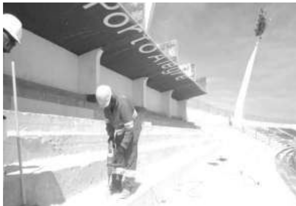
Recuperação de arquibancadas BEIRA RIO
