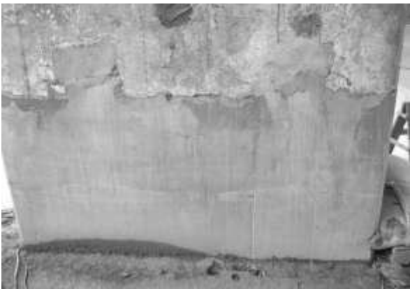
GRAUTEAMENTO com inibidor de corrosão
