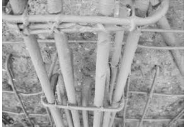
Pintura da armadura com PROTETOR contra corrosão
