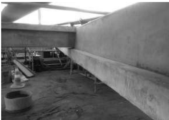
Recuperação estrutural PIER SÃO SEBASTIÃO PETROBRÁS
