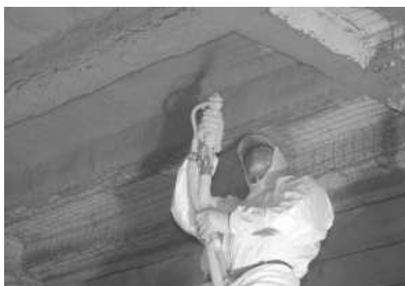
Recuperação de estrutura exposta à INCÊNDIO
