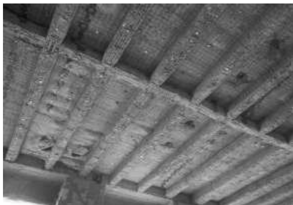
Recuperação de estrutura exposta à INCÊNDIO
