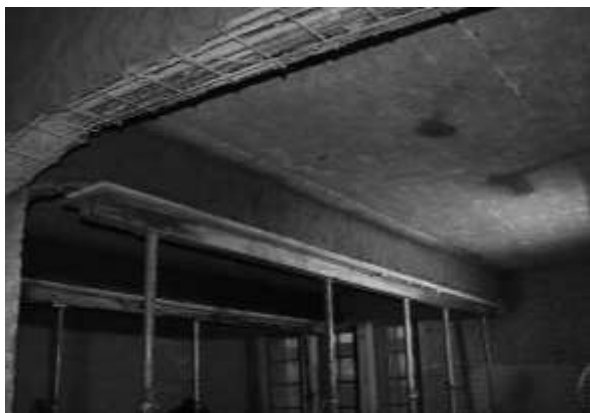
Recuperação de estrutura exposta à INCÊNDIO
