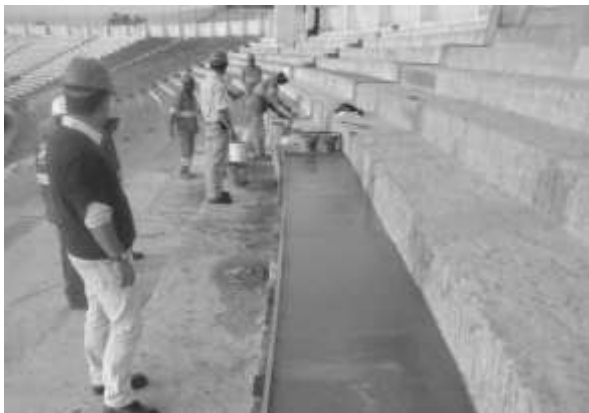
Recuperação de arquibancadas BEIRA RIO
