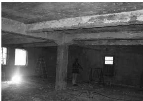
Recuperação de estrutura exposta à INCÊNDIO
