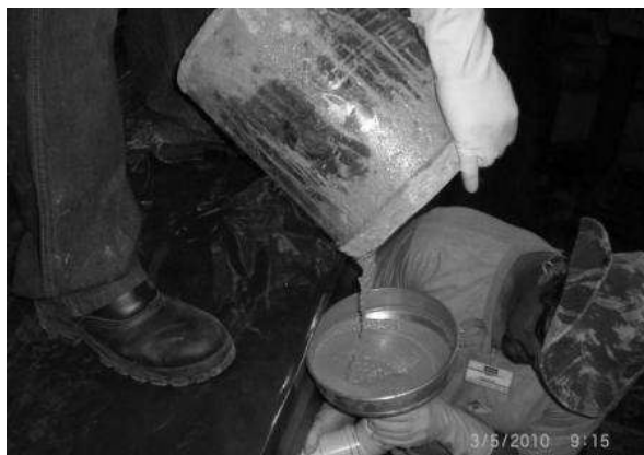
GRAUTEAMENTO EPOXÍDICO de base de máquinas
