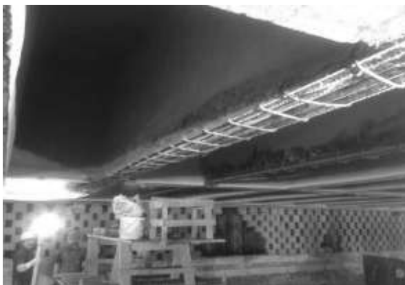
Recuperação estrutural PRAÇA ROOSEVELT
