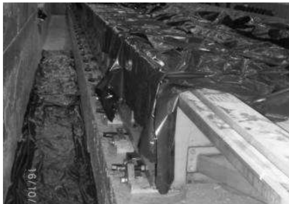
GRAUTEAMENTO EPOXÍDICO de base de máquinas
