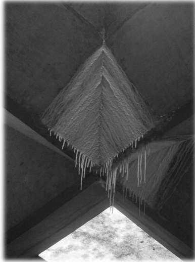
Cobertura do Prédio da FAU-USP
