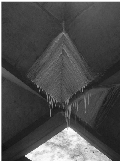
Cobertura do prédio da FAU-USP
