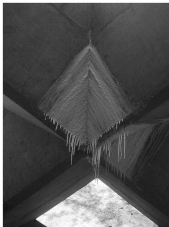
Cobertura do Prédio da FAU-USP
