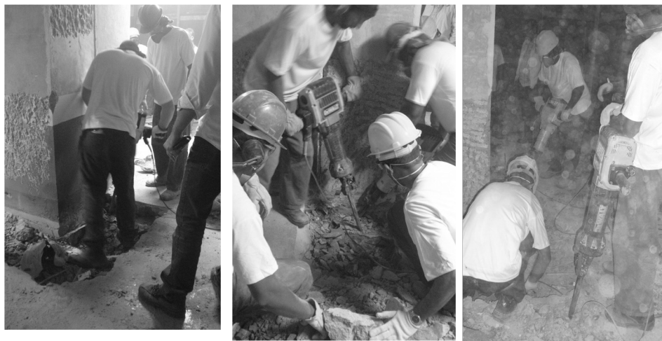
Demolição Piso fase 1
