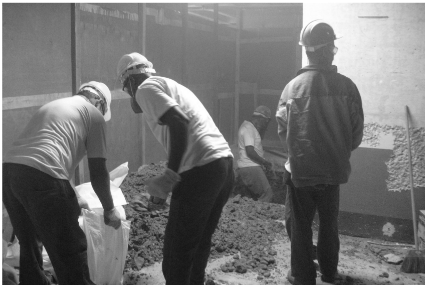
Escavação Piso fase 1
