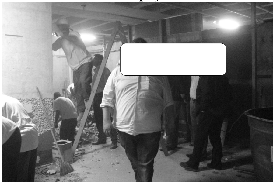
Escavação Piso fase 1
