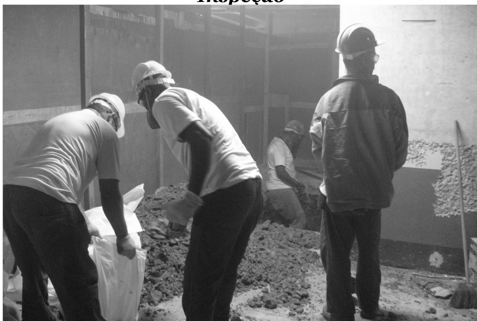
Escavação Piso fase 1
