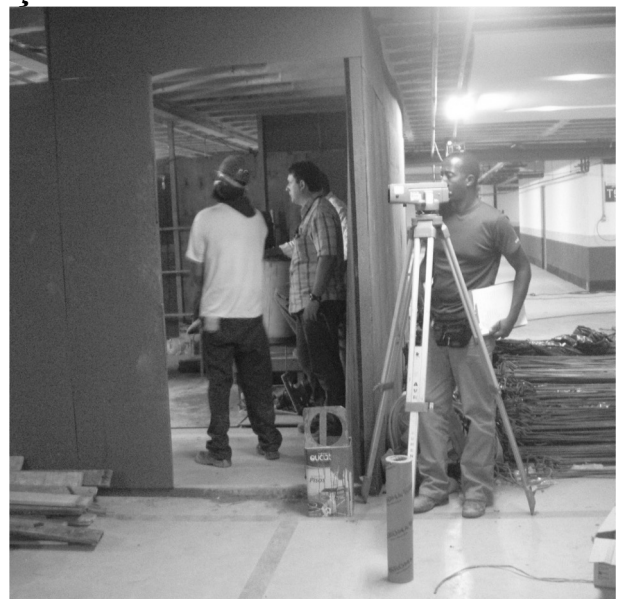
Controle contínuo de deslocamento vertical (recalque) dos pilares P1, P1A e P2
